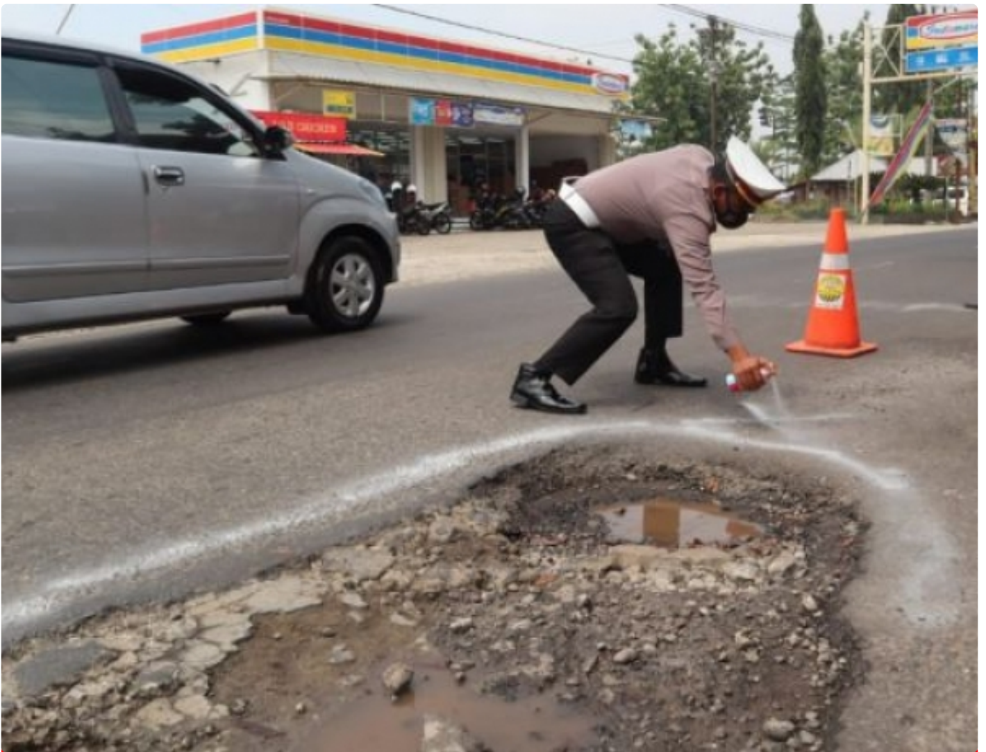
Satlantas Polres Purbalingga Survei Kondisi Jalan Jelang Operasi Ketupat 2022
